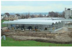
Bildungszentrum, 8330 Pfäffikon Gysi-Gewächshausanlage, 12-schiffig
